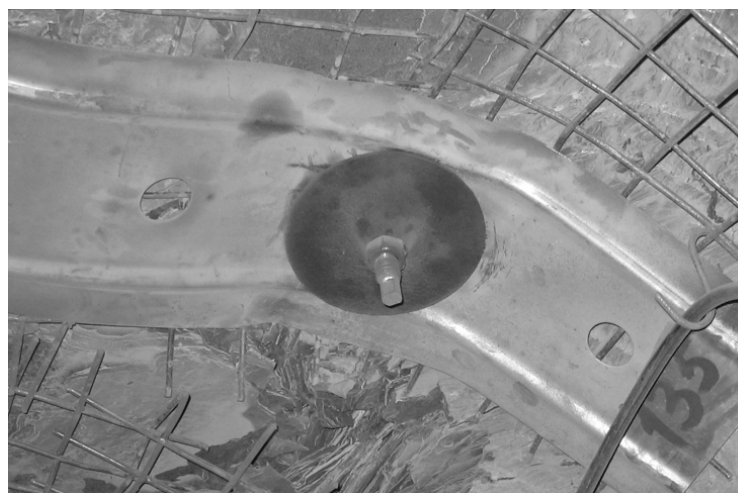
Рис. 2 – Анкер, установленный с применением опорной шайбы и подхвата
